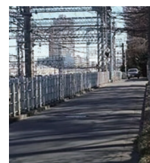
狭山ヶ丘駅側から 小手指駅方面を望む。
